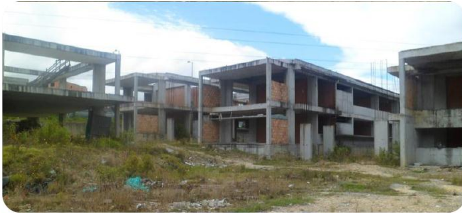
Imagen 1: Estado de la obra a mediados de agosto de 2007.
